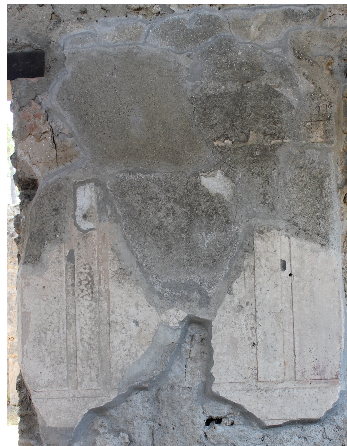
Fig. 2. Decorazione in Primo Stile ancora in situ, sulla parete sud dell’ambiente (9)
