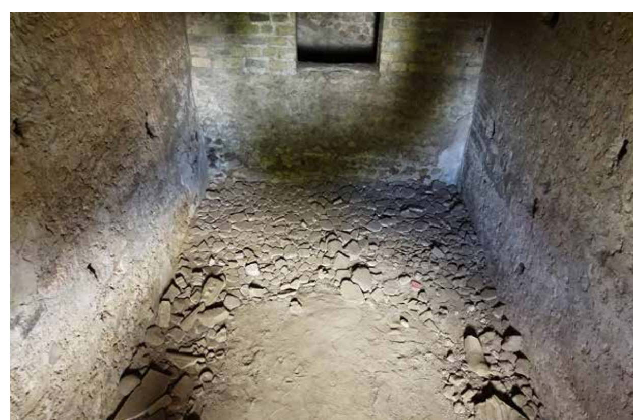
2. Ambiente (12), con i frammenti di intonaco, deposti a terra, al momento del rinvenimento.
